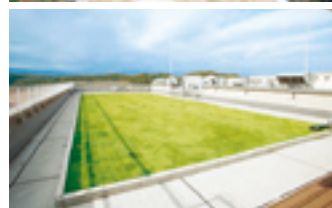
TFCP滝山工場の屋上緑化
