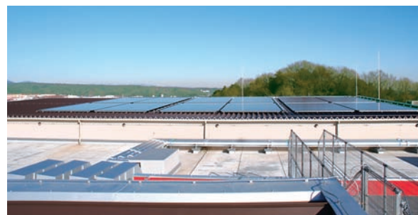
滝山工場屋上の太陽光発電パネル
