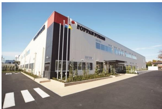
PCI DSS 準拠の専用エリアを構築する日野センター
