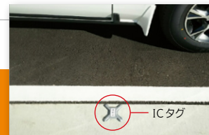
各駐車スペースの位置情報を ICタグに記録して設置
